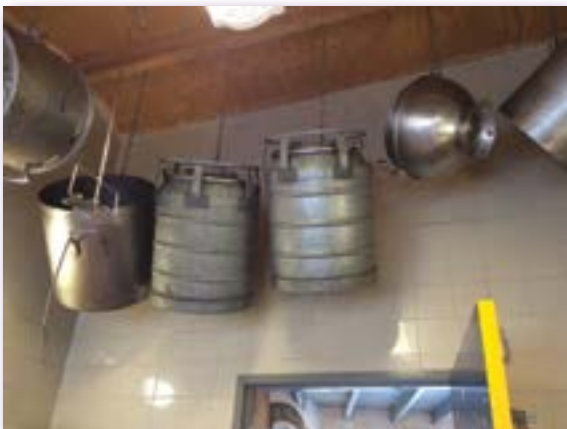
De keuken gaat een belangrijke plaats innemen in het gebouw. Keuken Scoutinggebouw Sint Paulus, Hilversum. Foto: Karin Bosman
